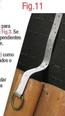
Amoldar la pata del ancla a la forma de la teja.
