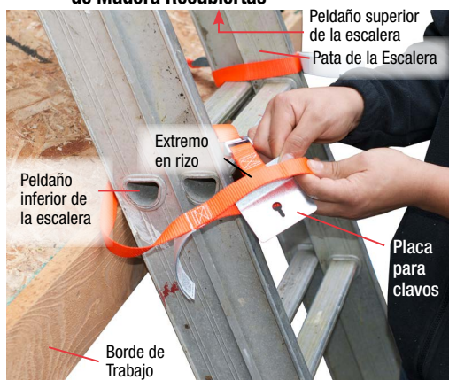
Fig.2 Instalación Sobre Armazones de Madera Recubiertas
